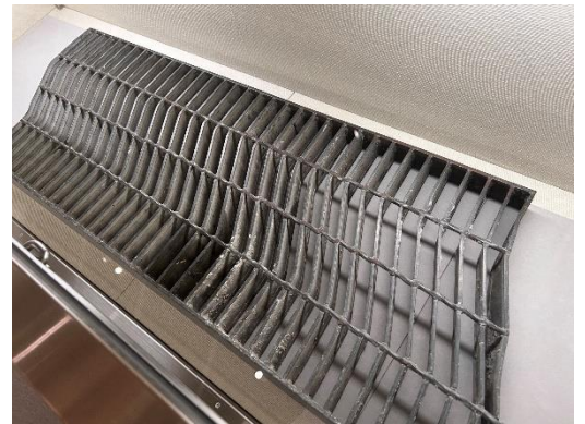
地震でゆがんだ側溝のふた 平成7年(1995年) 阪神・淡路大震災記念 人と防災未来センター蔵
