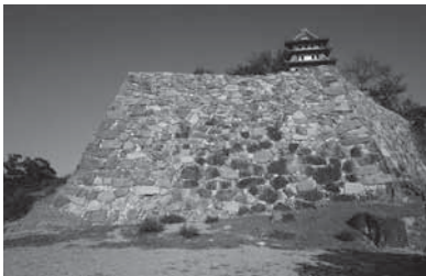
図13 修復後の石垣
