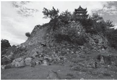
図12 崩落した石垣
