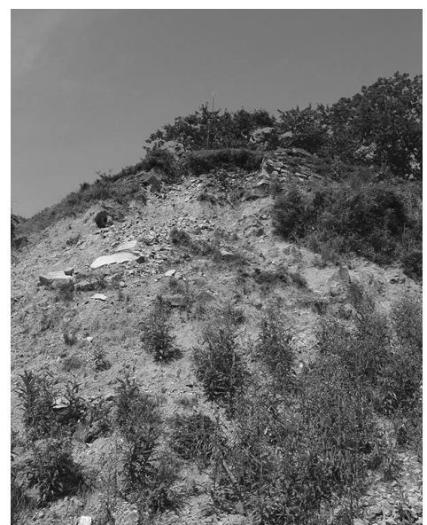
天守台の石垣の崩落
